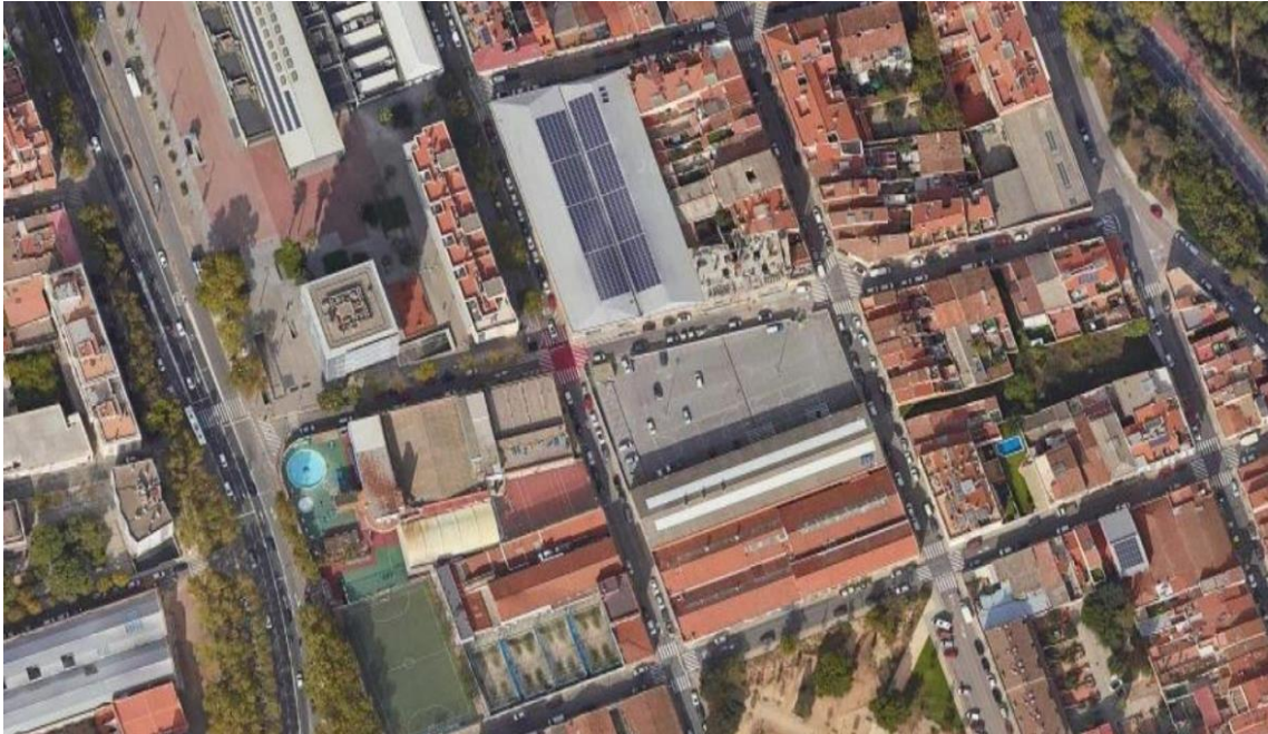
Coberta amb plaques fotovoltaïques del CN SABADELL (seu Gran Via)
